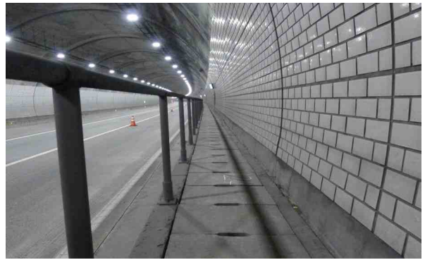
d. 공동구 전경
