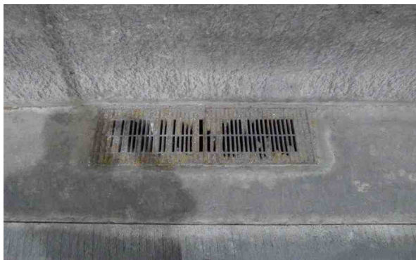
e. 배수시설 전경
