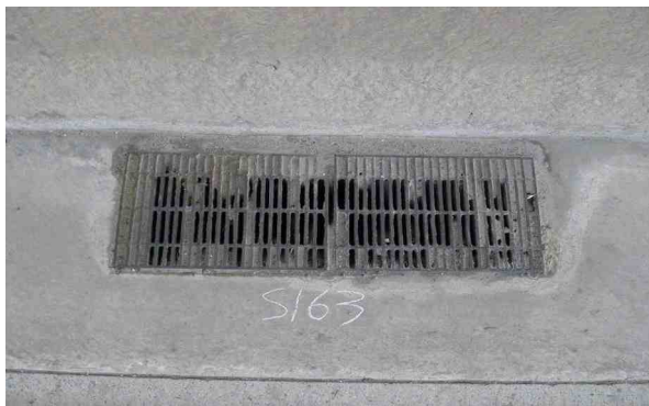
e. 배수시설 전경
