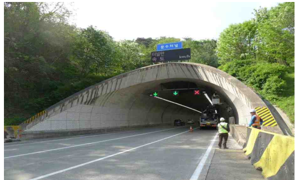
h. 갭문 및 사면 전경(종점)
