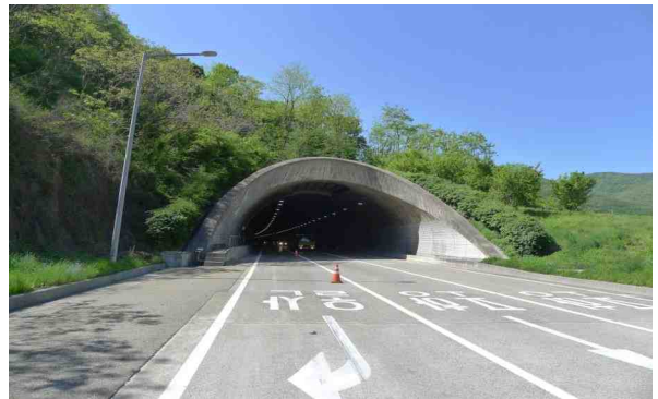
h. 갭문 및 사면 전경(종점)
